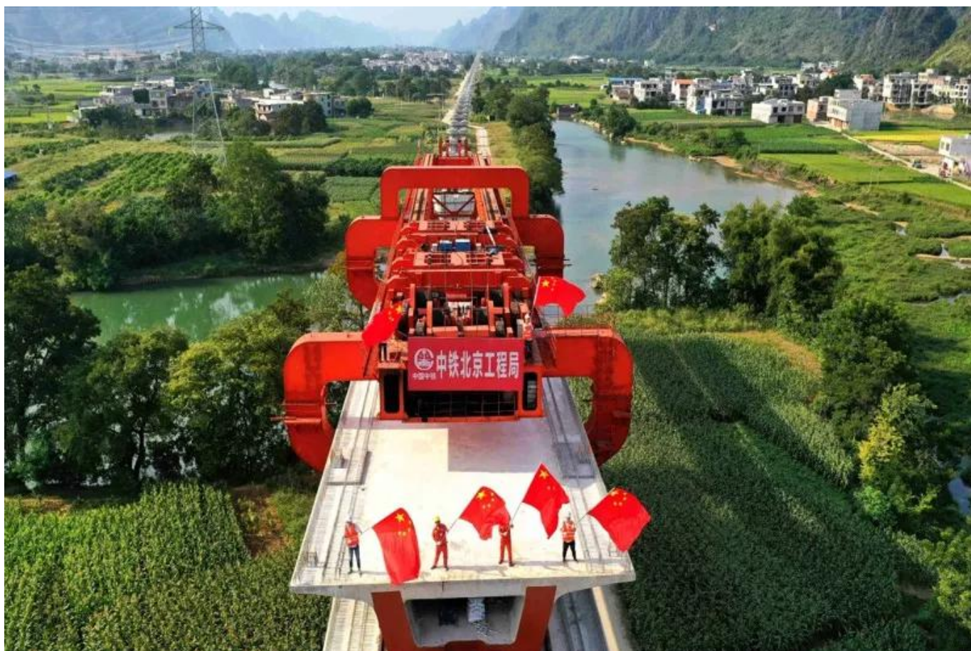
贵南高铁都安段建设如火如荼
